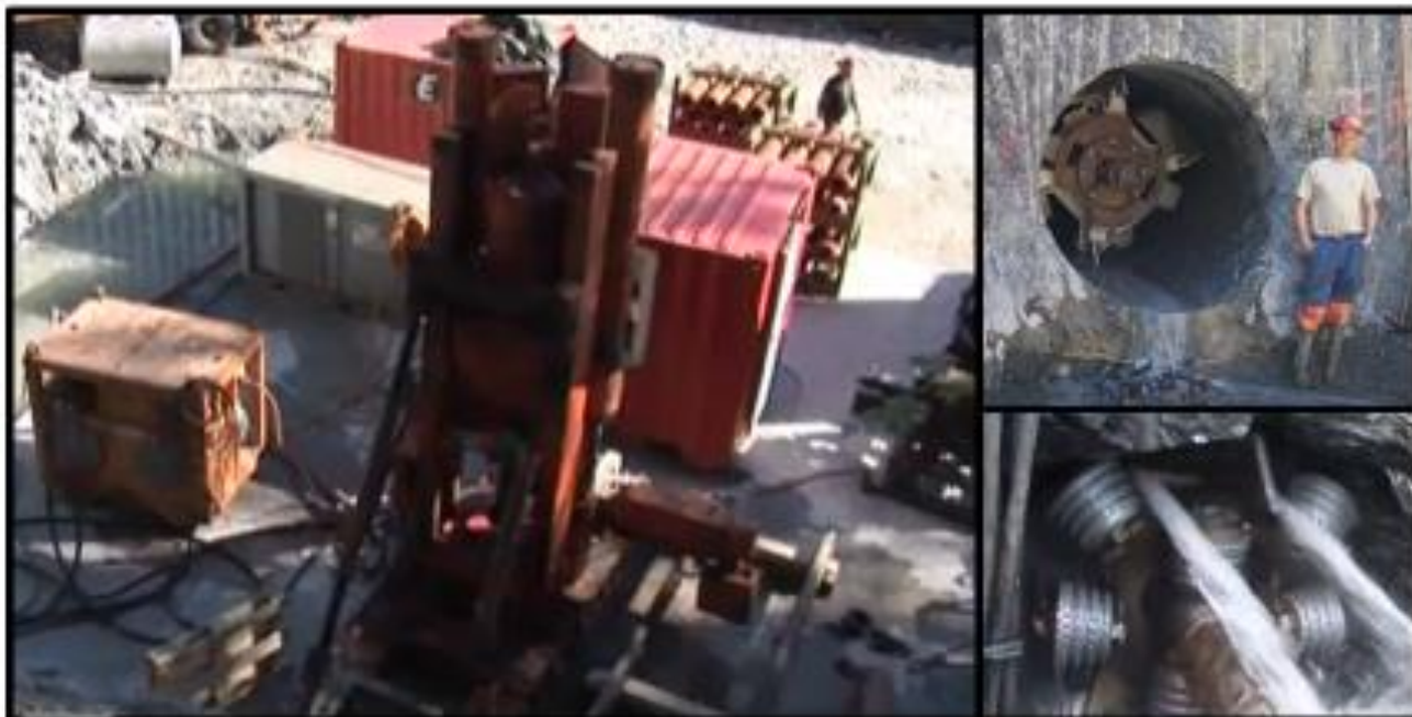
Figur 13 Bildene viser: Til venstre en typisk borerigg; oppe til høyre det ferdige hullet idet borekronen blir trukket tilbake; nede til høyre Borekronen rett etter gjennomslag.
